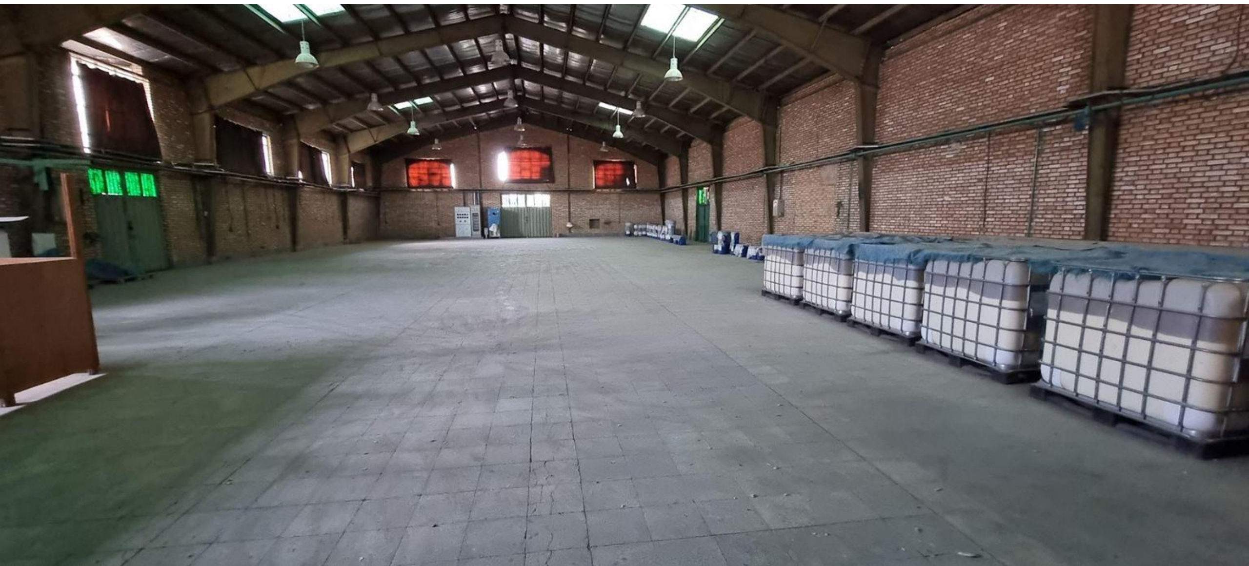
داخل انبار با تاسیسات
